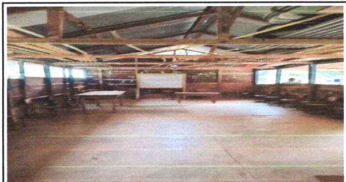
Foto 5: Se observa en el interior del aula a reforzar.
