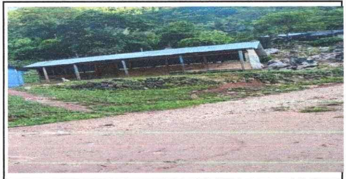
Foto 6: Se observa del lado de enfrente del aula a intervenir.
